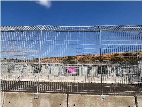
Hotspot Porto Empedocle, daneben ist das Grenzzentrum für Schnellverfahren entstanden
